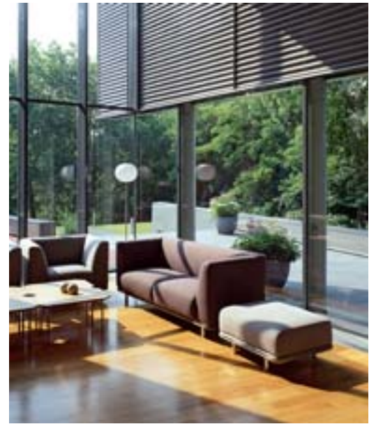
Die Wellblechverkleidung der Wandscheibe im Inneren läuft geradewegs nach außen durch.
